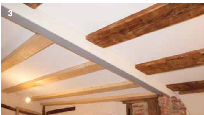
fertige Decke mit originalgetreuer Untersicht
