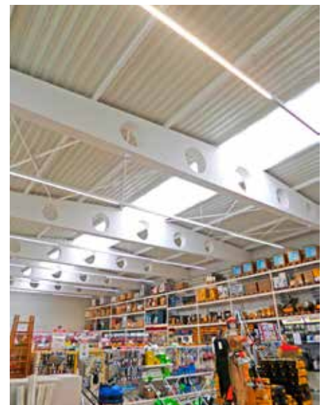
„TopHaus“ Baumarkt, Brixen: Die Klimadecke temperiert den bis zu 7,5 Meter hohen Raum gleichmäßig und effizient. Selbst im Rekordsommer 2015 genossen die Kunden und Mitarbeiter angenehm kühle Räume – bei Außentemperaturen über 35\text{ °C} .
