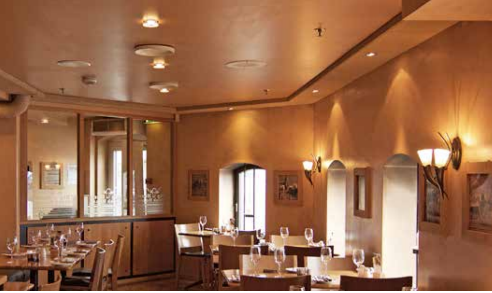
Ringabsorber am Deckenrand
