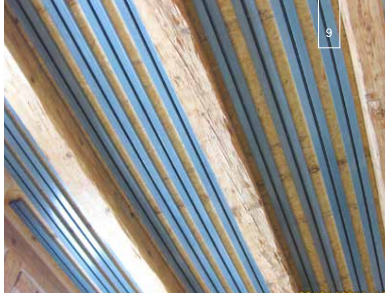
Direktmontage der Klimatop-Profile an einer Balkendecke
