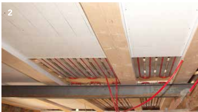
Klimatop-Profil zwischen den Balken verlegt und beplankt
