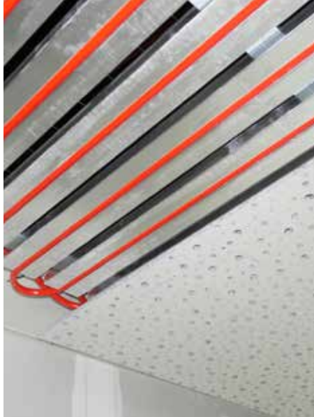
Abgehängte Klimadecke
